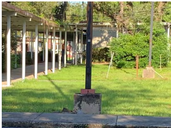
Fig. 4.9.8.D Misc. Overhead Utilities
